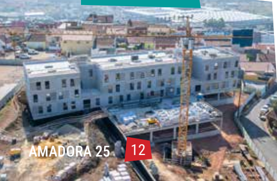
Construção de fogos no Cerrado da Mira
